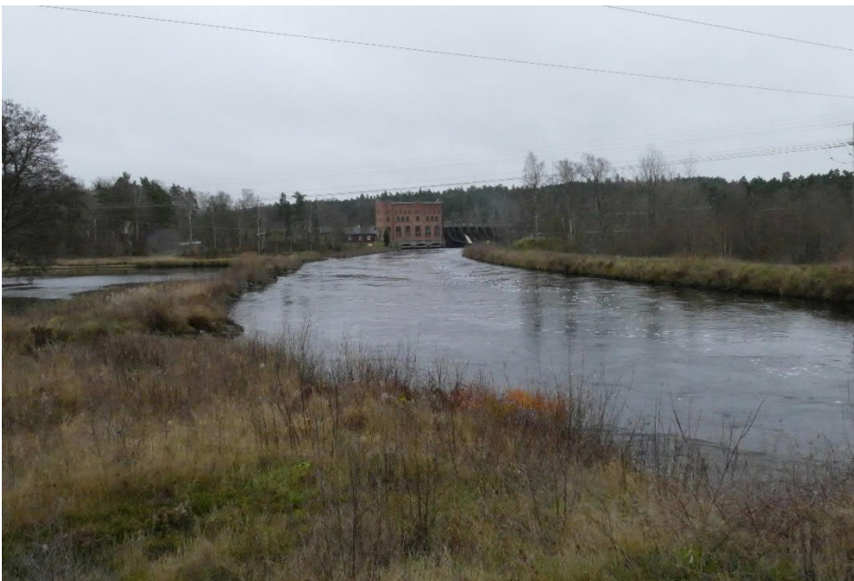
Figur 8-6. Knäredkanalen fotograferad i uppströms riktning. Kraftstationen för Knäred Övre syns i mitten av bilden. (Foto: Sweco, 2021)
