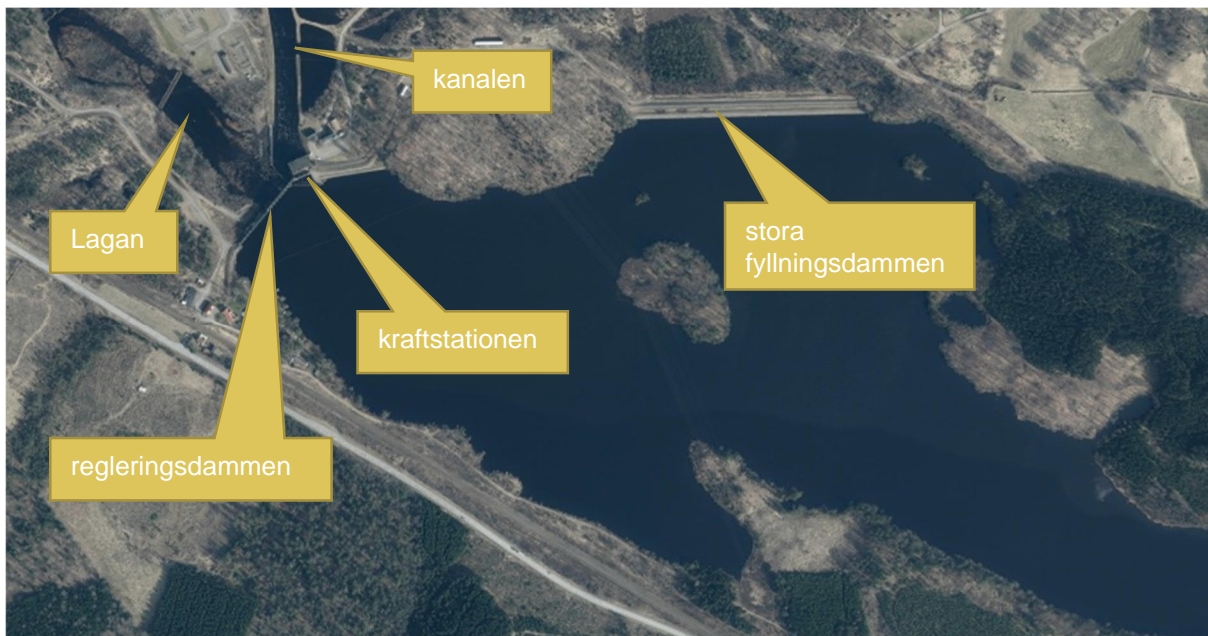
Figur 4-3 Anläggningen i Knäred Övre, Lagan rinner åt vänster i bild (Foto från https://minkarta.lantmateriet.se/ ).
